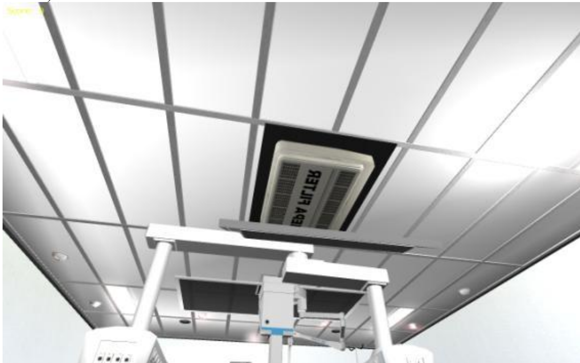
Ilustración 10 - Intercambio de filtro HEPA en el quirófano
